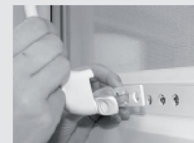
Pour installer cette câle, il faut démonter la poignée de la fenêtre, positionner la câle puis replacer la poignée, comme le montrent les photos ci-contre.
