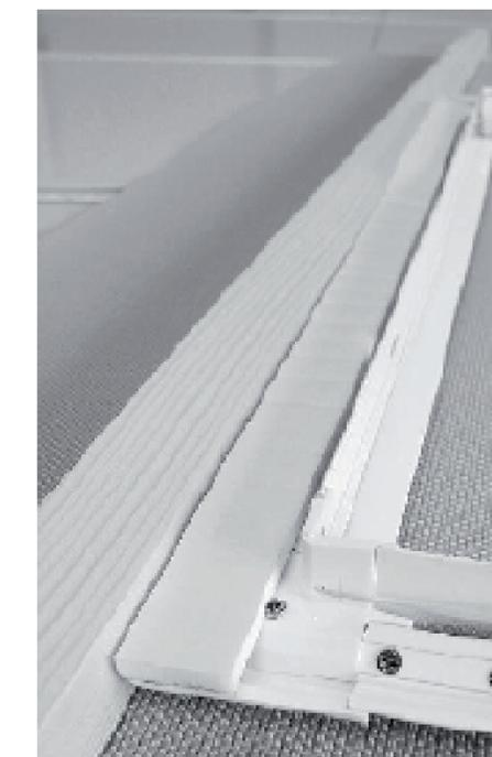
Ce jour peut être compensé par un joint adhésif qui vous sera fourni dans ce cas de figure. Pour installer le joint, placez-vous contre une surface droite et positionner le joint tout autour du cadre en suivant le bord des profils, comme indiqué dans les photos ci-contre.
